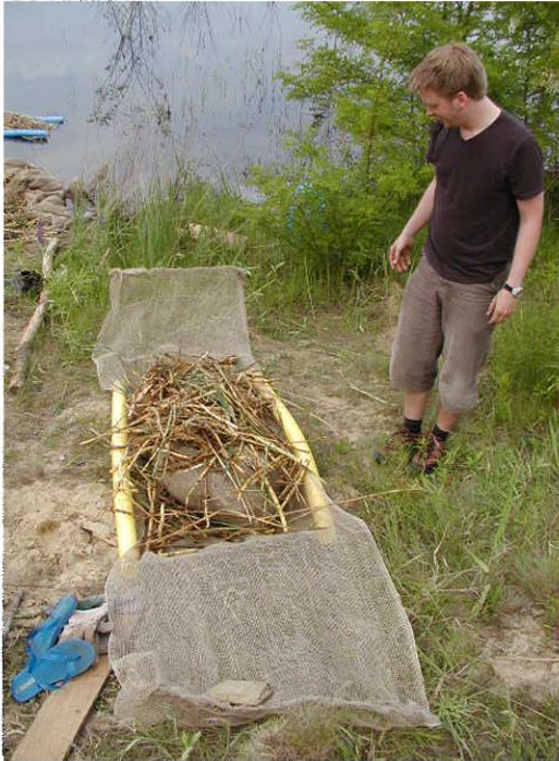
Abb. 5: Bau und Füllung einer schwimmenden Gabione (05/2002)
