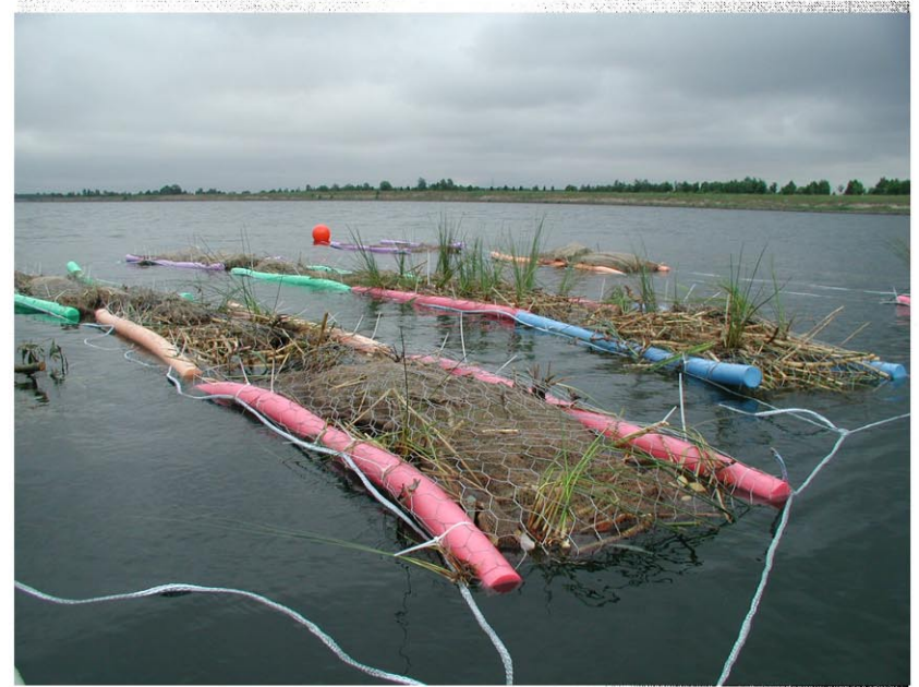
Abb. 6: Anordnung der schwimmenden Gabionen auf dem Wasser (05/2002)
